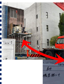
高所への新旧空調設備入替の様子
