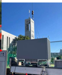
高所への新旧空調設備入替の様子
