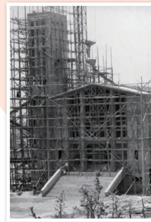
建設中のチャペル
